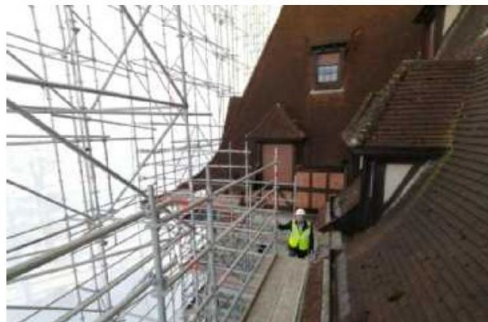
L'échafaudage pèse 120 tonnes. Il monte à 27 mètres. La vue sur les toits de Chanteloup est inédite. o.s.
