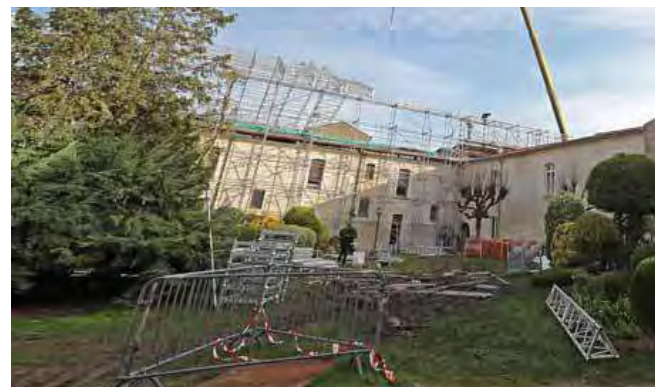
Le jardin de la maison Martineau chamboulé par le chantier
